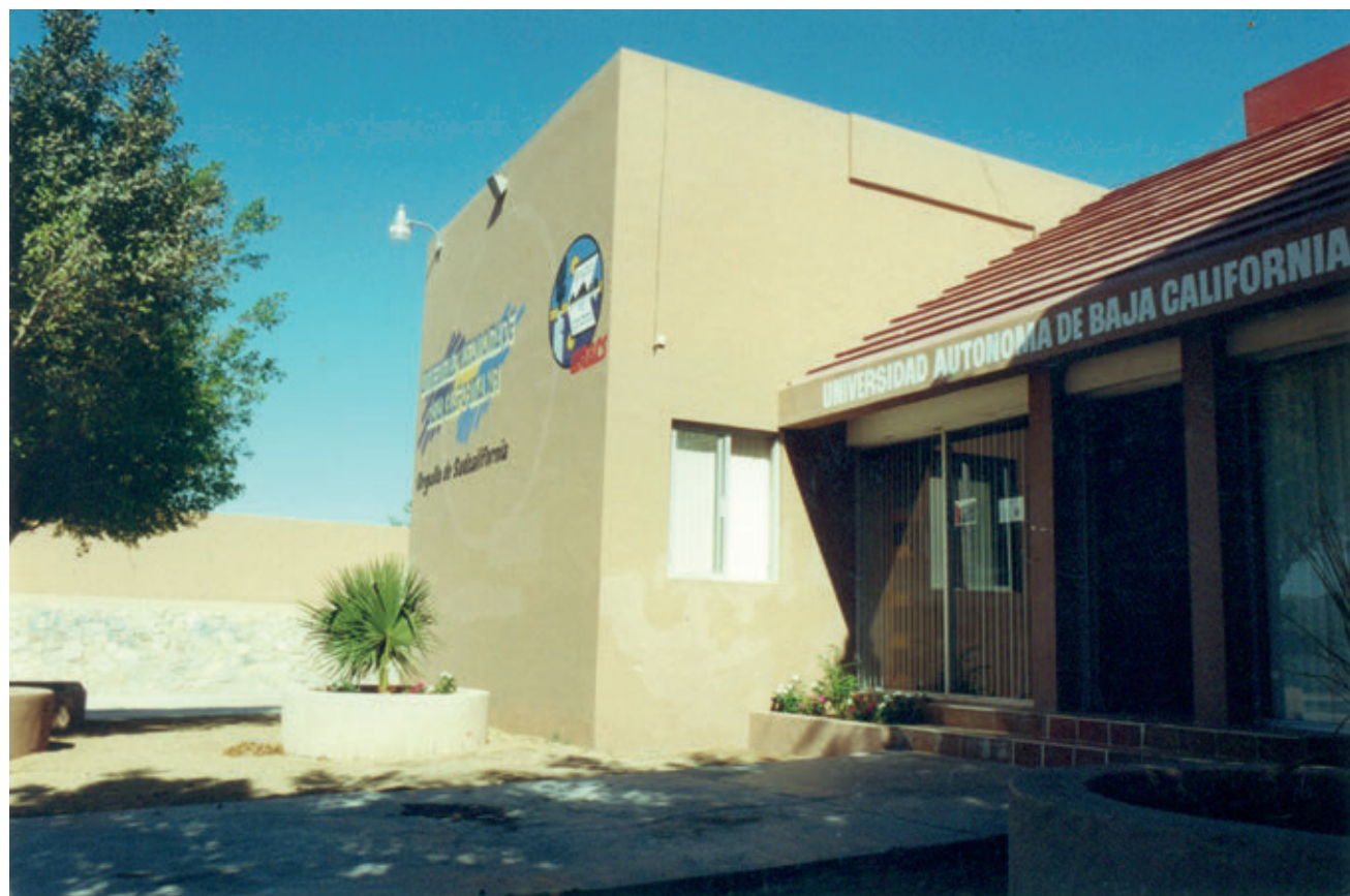
Fachada del primer edificio construido en la Extensión Académica de Los Cabos
