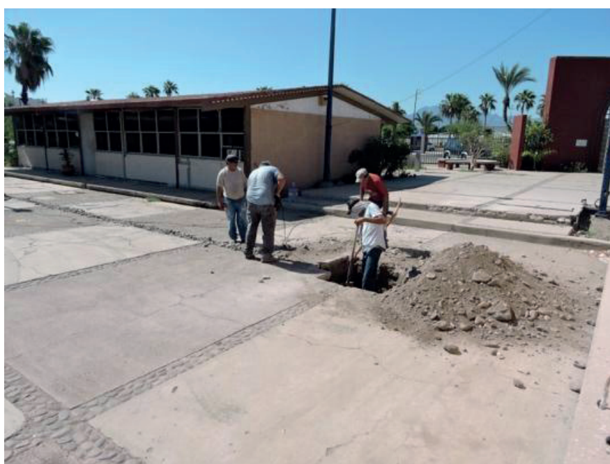
Figura 1 Instalación de fibra óptica en la Extensión Académica Loreto, 2015
