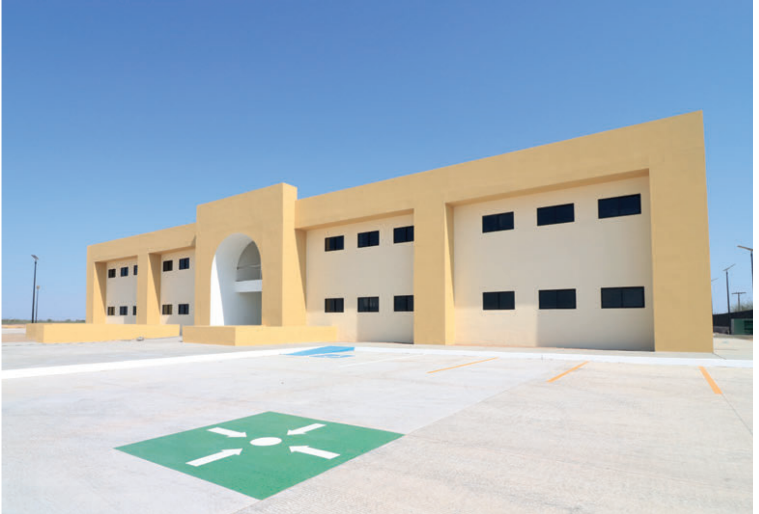
Edificio principal de la Extensión Académica Ciudad Insurgentes. Vista angular
