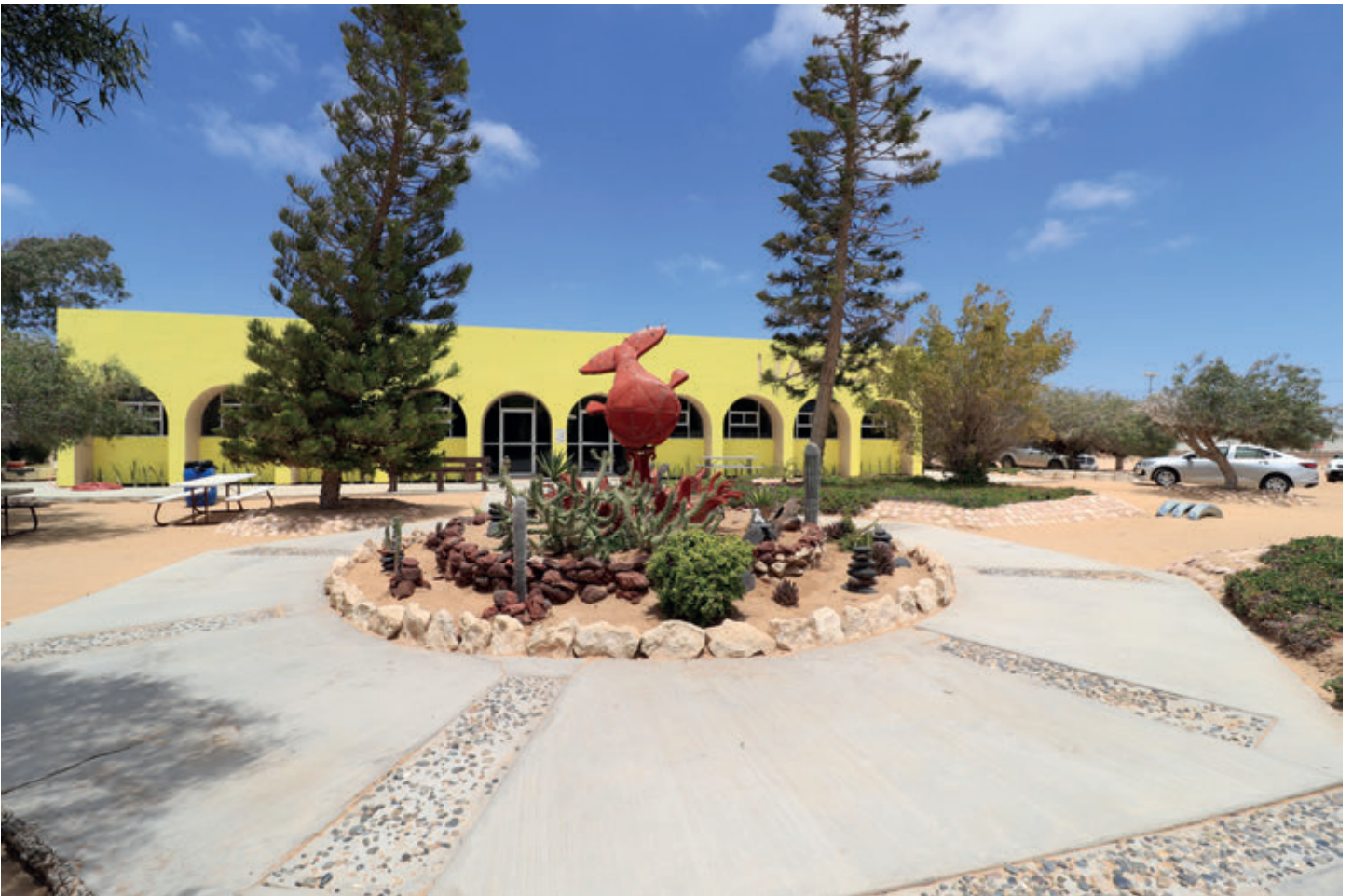
Edificio "A" de la Extensión Académica Guerrero Negro. Vista frontal
