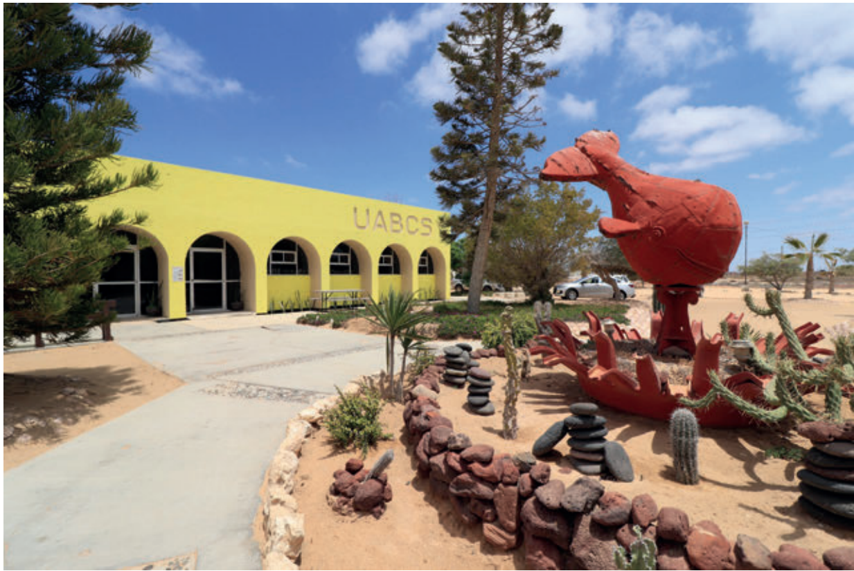
Edificio "A" de la Extensión Académica Guerrero Negro. Vista angular
