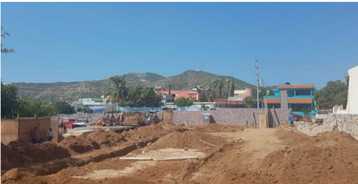
Inicio oficial a las obras de construcción de un edificio que consta de dos plantas y nueve aulas
